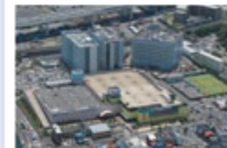
A13 maricom-ISOGO・システムプラザ横浜(敷地) (注) maricom-ISOGO / SYSTEM PLAZA YOKOHAMA (Site)
