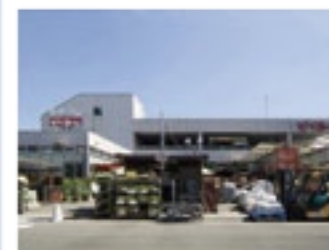
A27 ビバホーム横浜青葉店(敷地) (注)
