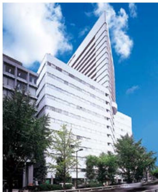
B6 新大阪セントラルタワー
