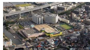
【maricom-ISOGO・システムプラザ磯子(敷地)】
