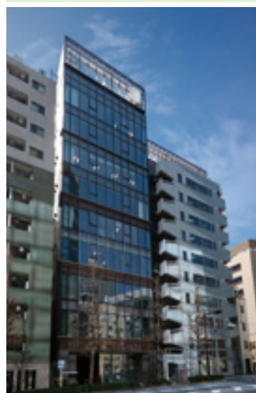
UUR京橋イーストビル
