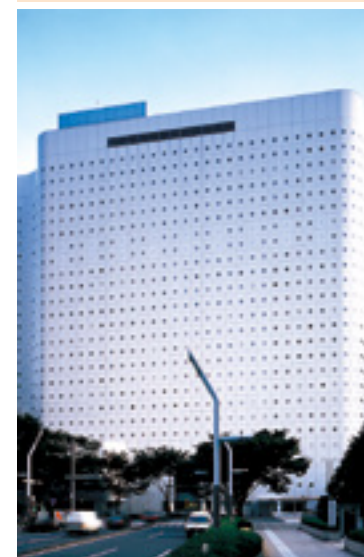
新宿ワシントンホテル本館
