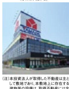
A28 ヤマダ電機テックランド 青葉店(敷地) (注)
