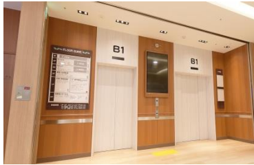
デジタルサイネージを設置した エレベーターホール
