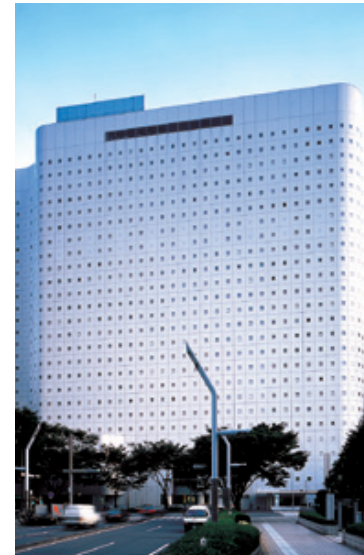
新宿ワシントンホテル本館
